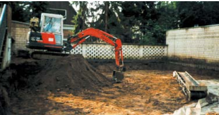
Belasteter Oberboden wird bis zu 1 m abgetragen.
