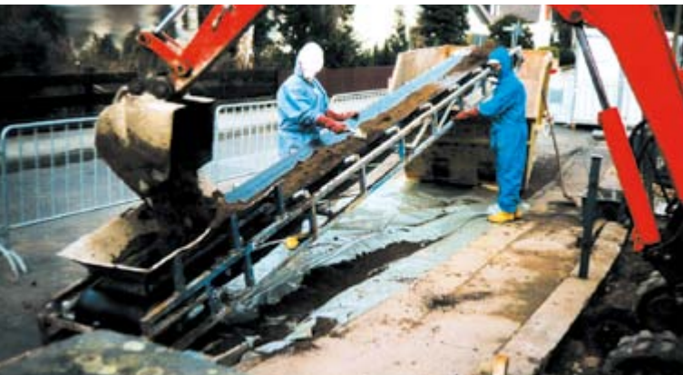
Makroskopisch sichtbare TNT-Stücke werden über Förderbänder separiert
