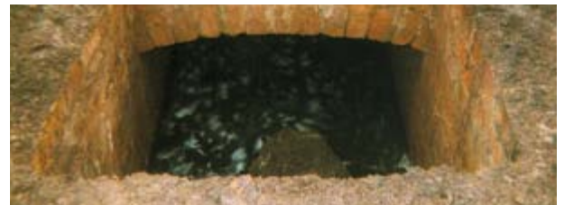
Alter Abwasserkanal der ehemaligen Carbonit AG
